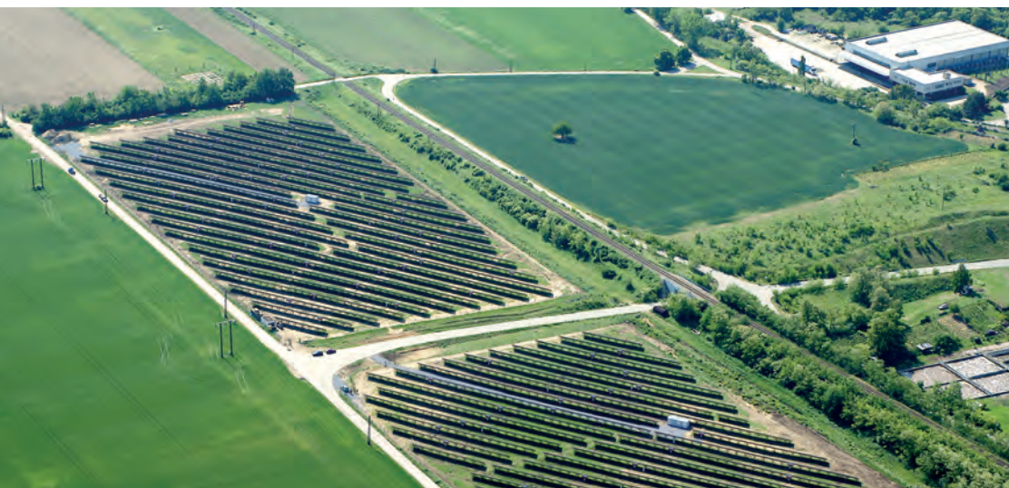
Proyecto fotovoltaico Hodonice/CZ, finalización en primavera de 2009
